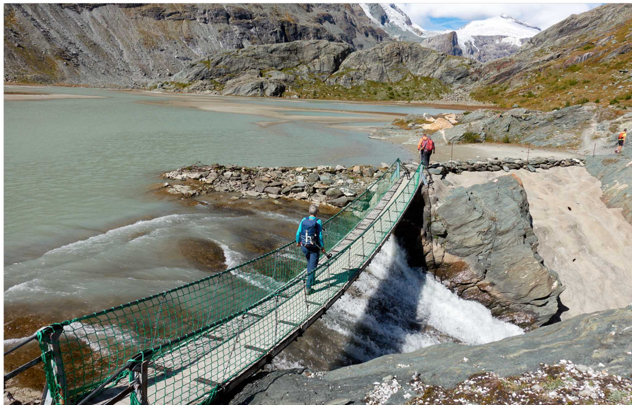
Dit bruggetje gaat over de afvoer van de Sandersee.
