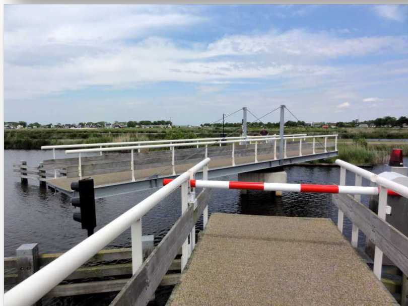
Draaibrug in fietspad bij Giethoorn
